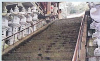
初詣の神社階段の勾配、階段の踏み幅、手摺りの強度等を確認
