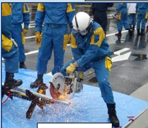
支柱切断訓練
