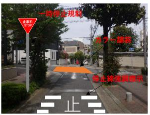
交差点が目立つようにカラー舗装を検討します。 東行き道路を一時停止規制とし、停止線が分かりやすいように強調標示
