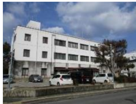
【長寿命化改修中のたつの警察署】
